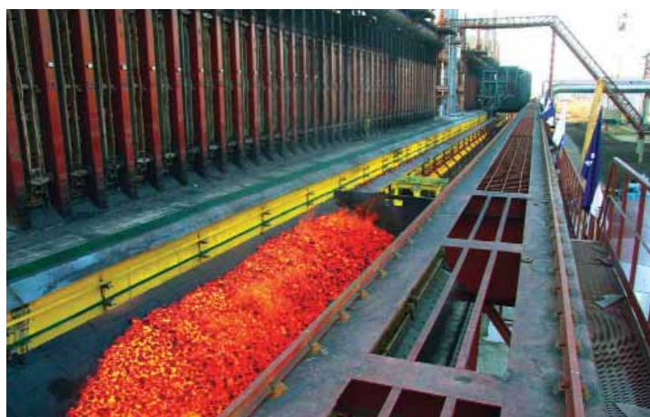
Производство кокса на ОАО «Алтай-кокс»
